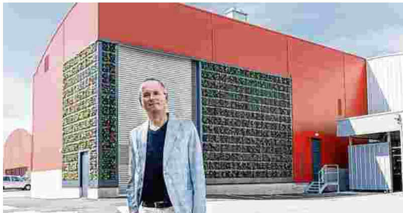
Geschäftsführer Christian Peneder vor der begrünten Fassade
